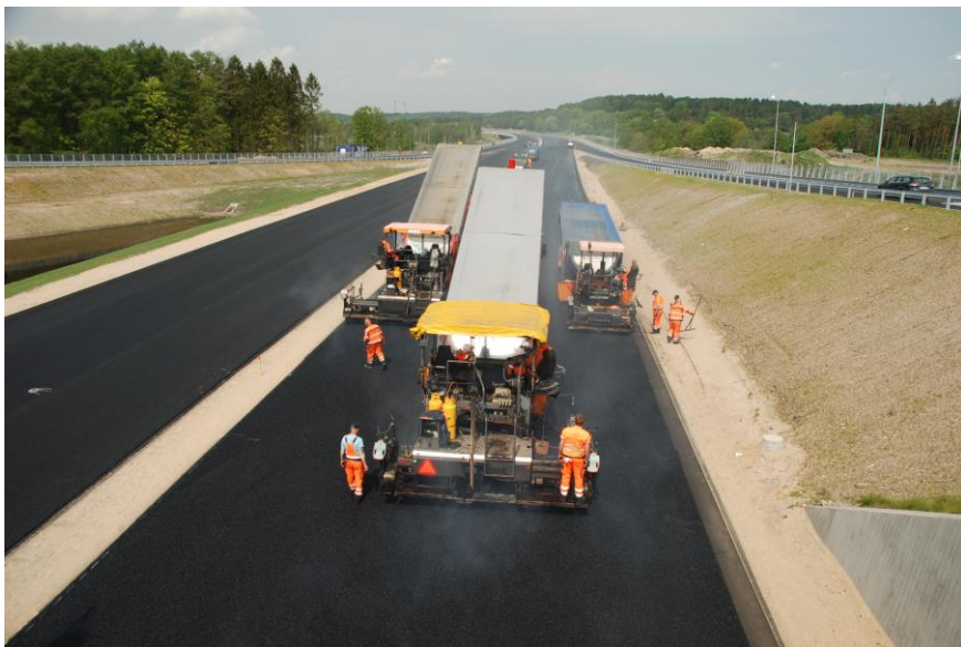
Udlægning af støjreducerende asfalt SMA 8 SRS ved Silkeborg.
